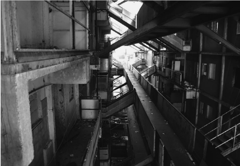
5 Die Gangway-Struktur einer Wohneinheit der Vele-Siedlung. Aktueller Zustand
